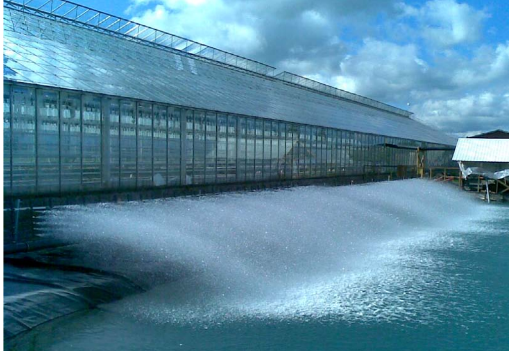
-Figuur 6- Koeling van het water uit de kas in het bassin
