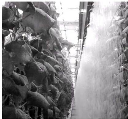
-Figuur 2- Vallende waterdruppels vormen een watergordijn dat warmte en vocht uit de kaslucht opneemt. Een opstelling per 10 m levert een koelvermogen van gemiddeld 500 W/m 2 . Rechts de opvanggoot.
