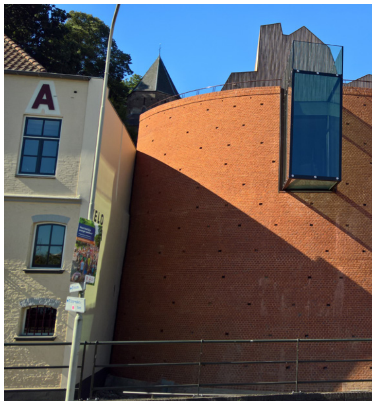
Foto 2: Ook onderdeel van het museum: de Stratemakerstoren aan de Waalkade. Die kreeg een nieuwe bakstenen schil en een uitstulpende glazen erker, vanwaar bezoekers een prachtig uitzicht hebben op Waal en achterliggend landschap.
