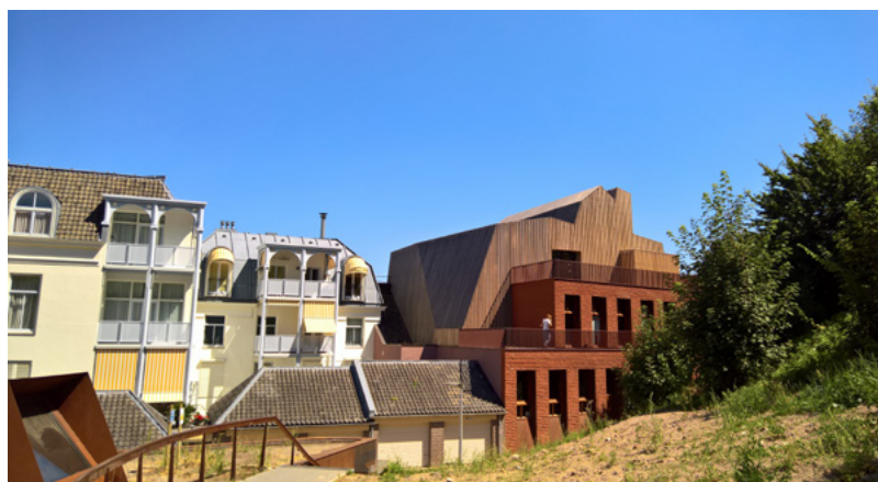
Foto 10: Brandcompartimentering: in het mergelwerk is een gleuf gezaagd, waarin het scherm naar beneden gelaten wordt.
