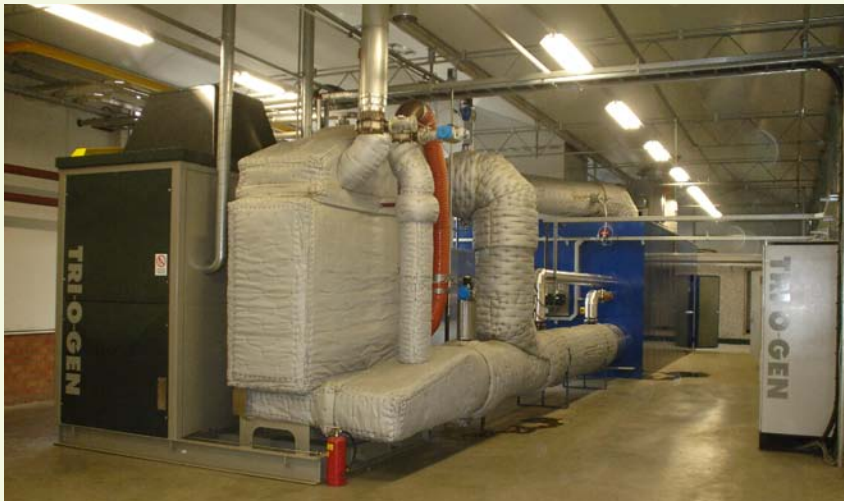
-Figuur 9- Demonstratie ORC in combinatie met gasmotor bij een rozentuinder
