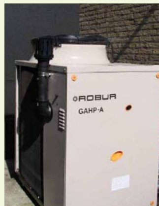
De gasabsorptiewarmtepompen bij de drie zwembaden van Sportfondsen Nederland, van links naar rechts: Didam, Roelofarendsveen en Rotterdam
