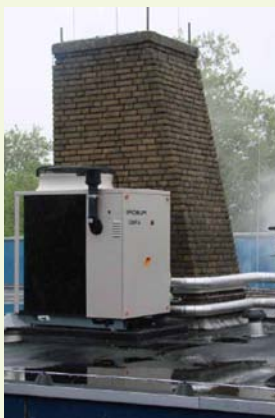
De gasabsorptiewarmtepompen bij de drie zwembaden van Sportfondsen Nederland, van links naar rechts: Didam, Roelofarendsveen en Rotterdam
