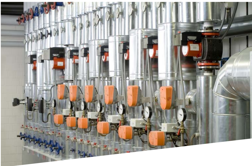
-Figuur 1- Het regelsysteem BOA-Systronic verlaagt het stroomverbruik van pompen in verwarmings- en koelinstallaties
