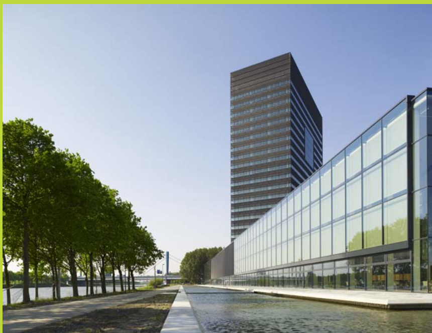
-Figuur 1- Kantoorcomplex Westraven langs het Amsterdam-Rijnkanaal. (foto: Jannes Linders)
