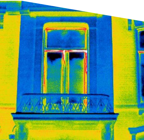
-Figuur 5- Infraroodopname van een oud herenhuis, om aan te geven waar zich mogelijke thermische gebreken bevinden.
