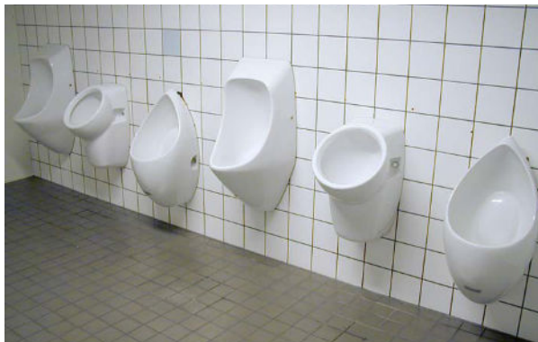
Figuur 4.6: Verschillende waterloze urinoirs, Duravit, Sphinx en Urimat [Demiriz 2005].
