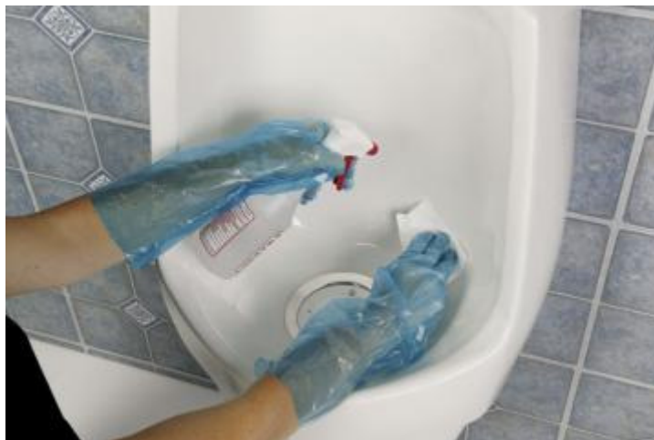
Figuur 8.1: Schoonmaken van een urinoir met een milde reiniger en een doekje.
