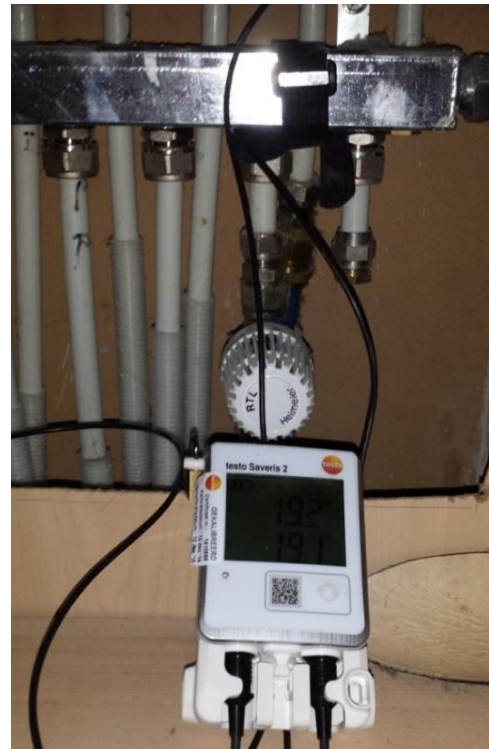
Foto 1.13 Plaatsing van de op de verdeler.
