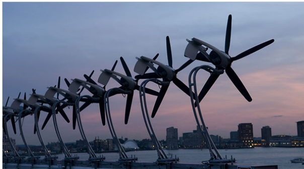
Figuur 18: Kleine windturbines voor de gebouwde omgeving (urban turbines) (Logan International Airport in Boston)
