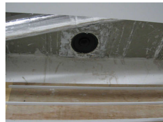
Afbeelding 1: luidspreker gemonteerd in doorvoering
