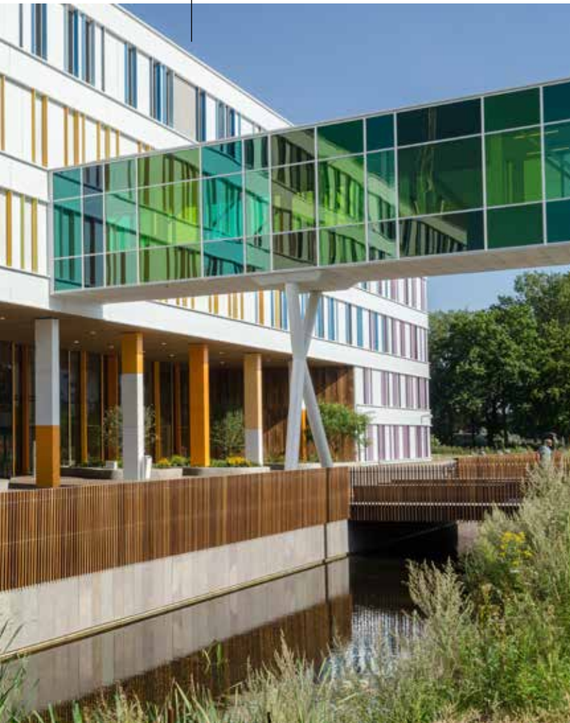
Foto 1: Het nieuwe Prinses Maxima Centrum is via een loopbrug verbonden met het Wilhelmina Kinderziekenhuis. Zowel binnen als buiten is veel met natuurlijke materialen gewerkt, zoals bamboe.
