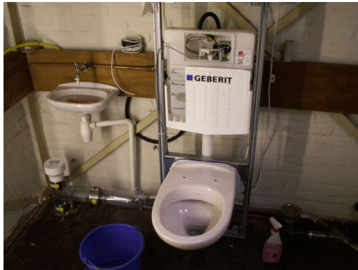
figuur 4-2 Watercloset van de meetopstelling
