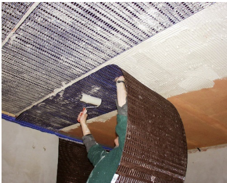
Figuur V-7 Aanbrengen van capilaire verwarmingsmatten tegen het plafond (BioClima).
