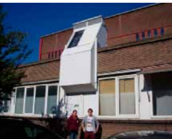
-Figuur 5- Voorbeeld van een laboratoriumopstelling van een zonneshoorsteen bedoeld voor te renoveren woningen met volledige natuurlijke ventilatie in Heijlplaat
