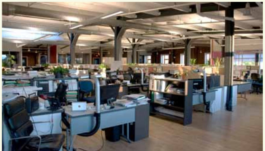
-Figuur 7- Persoonlijke ventilatie in een grote open kantoortuin in de VS [21]
