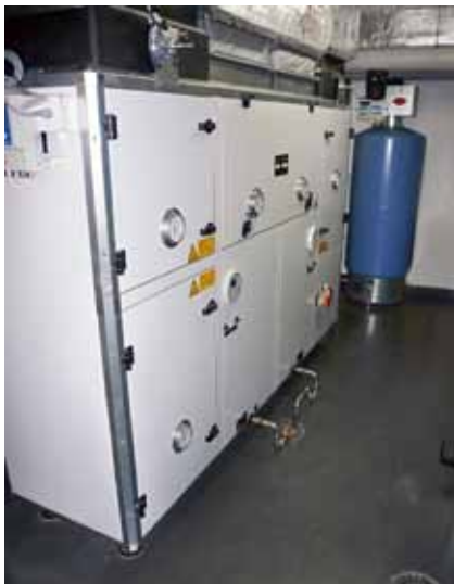
-Figuur 3- De RLT-units van het type Optima ME van het bedrijf Bösch voldoen aan de laatste inzichten op het gebied van energie en hygiëne, en aan al de huidige normen voor energiezuinige apparatuur (foto: Bösch)
