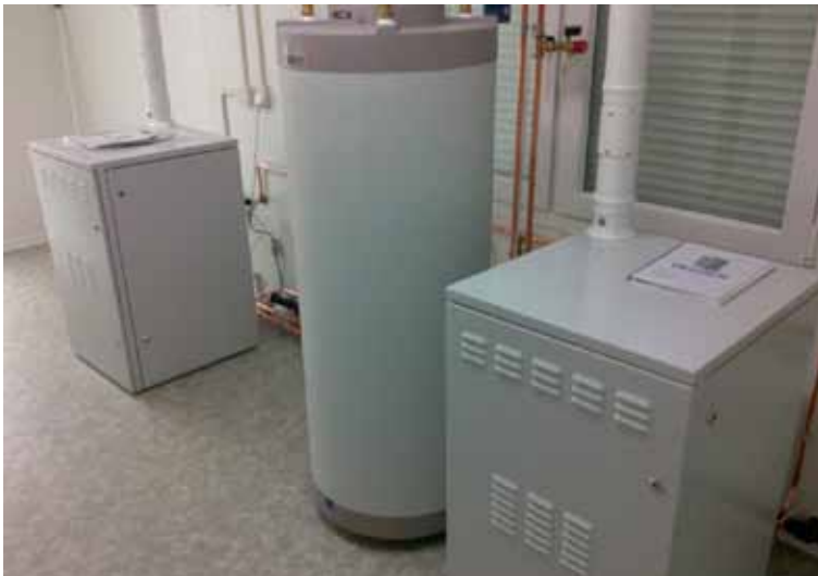
-Figuur 3- Twee SOFC-brandstofcellen gecombineerd met een warmwateropslagvat (elk 1,5 kW elektrisch en 500 W warmte) (bron: Bluegen, 2013)
