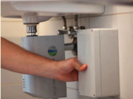
Figuur 5. Thermisch desinfecterende sifon
