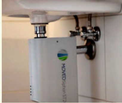
Figuur 5. Thermisch desinfecterende sifon
