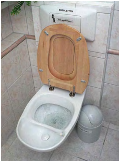
-Figuur 3- Scheidingscloset: sinds het begin van de 21e eeuw doet de 'nieuwe sanitatie' zijn intrede met de scheiding aan de bron van een afvalwaterstromen
