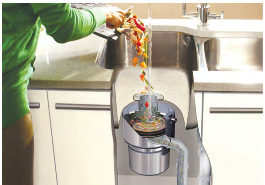
-Figuur 4- Het toevoegen van organisch (keuken) afval aan de waterstroom is een optie om de concentratie van materiaal te verhogen. Om het materiaal in de riolering te brengen moet echter geen water worden gebruikt, zoals hier afgebeeld.
