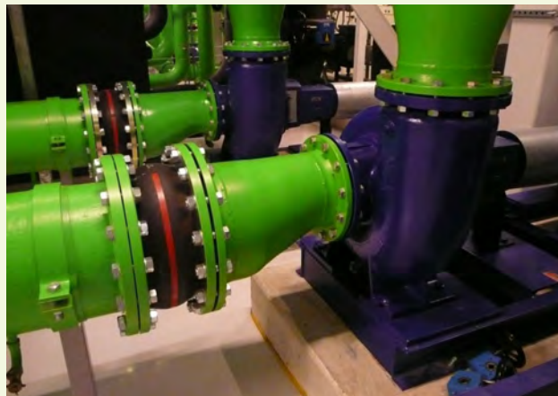
-Foto 1- Correct gemonteerd excentrisch verloop met compensator aan de zijde met de grootste diameter
