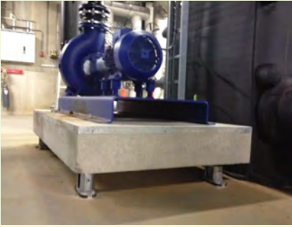
-Foto 3- Afbeelding van een pomp op een massaveerstysteem
