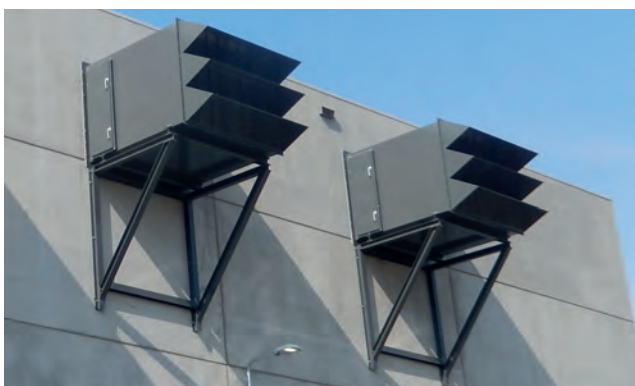
▲ VUMC (AMSTERDAM) - Geluidsabsorberende wanden, panelen en ventilatieroosters ▼ PRAXAIR (ANTWERPEN) - Absorptiepanelen en akoestisch ventilatiesysteem met dempers
