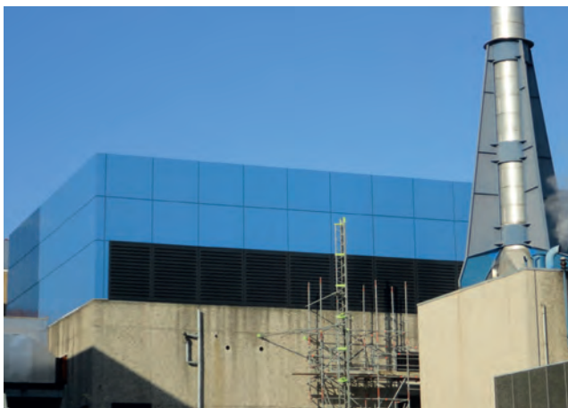
▲ VUMC (AMSTERDAM) - Geluidsabsorberende wanden, panelen en ventilatieroosters ▼ PRAXAIR (ANTWERPEN) - Absorptiepanelen en akoestisch ventilatiesysteem met dempers
