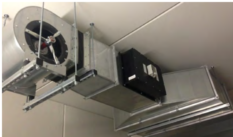
-Figuur 2- Voorbeeld van Active Noise Control in een luchtkanaal. In de zwarte doos is de volledige antigeluidoplossing opgenomen
