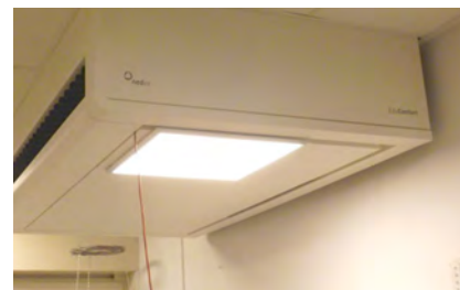
-Figuur 8- Nieuwe ITHO ventilatie-unit, 950 m 3 /h (links) en nieuwe Ned Air ventilatie-unit, 950 m 3 /h
