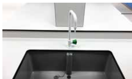
Foto 2: Aan kranen in lokalen en laboratoria mogen geen slangen worden bevestigd
