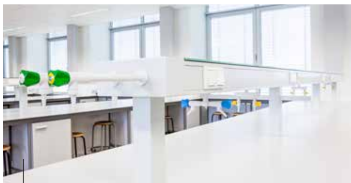
Foto 5: Tapkranen moeten gangbaar worden gehouden.
