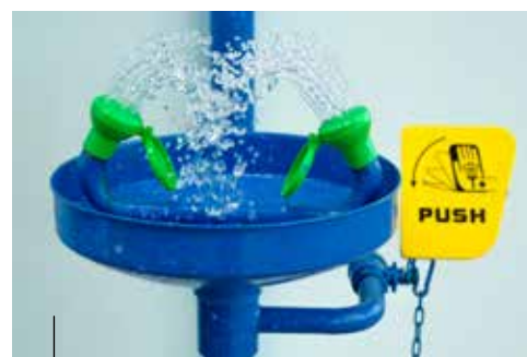
Foto 4: Oog- en gelaatsdouches worden uitsluitend doorstroomd aangesloten.
