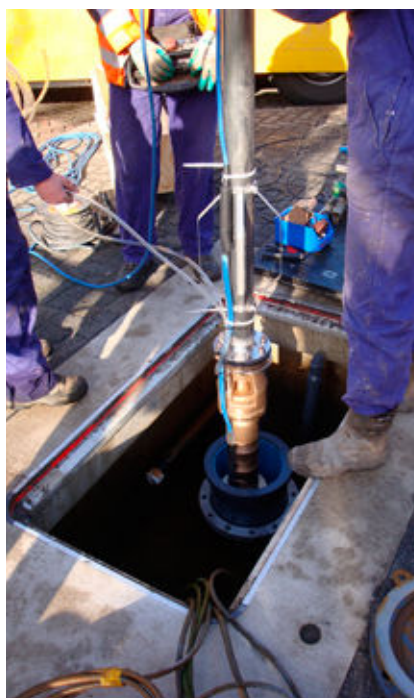
-Foto 4- Inbouw van een bronpomp
