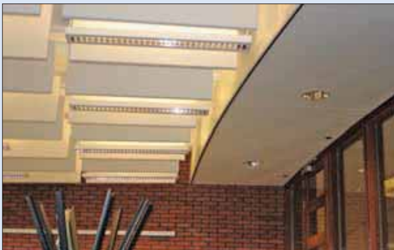
Plafond in de kantoren.
