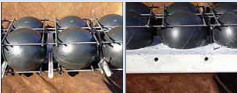
Bubble-deckvloer met de leidingen voor de betonkernactivering, voor het volstorten.
