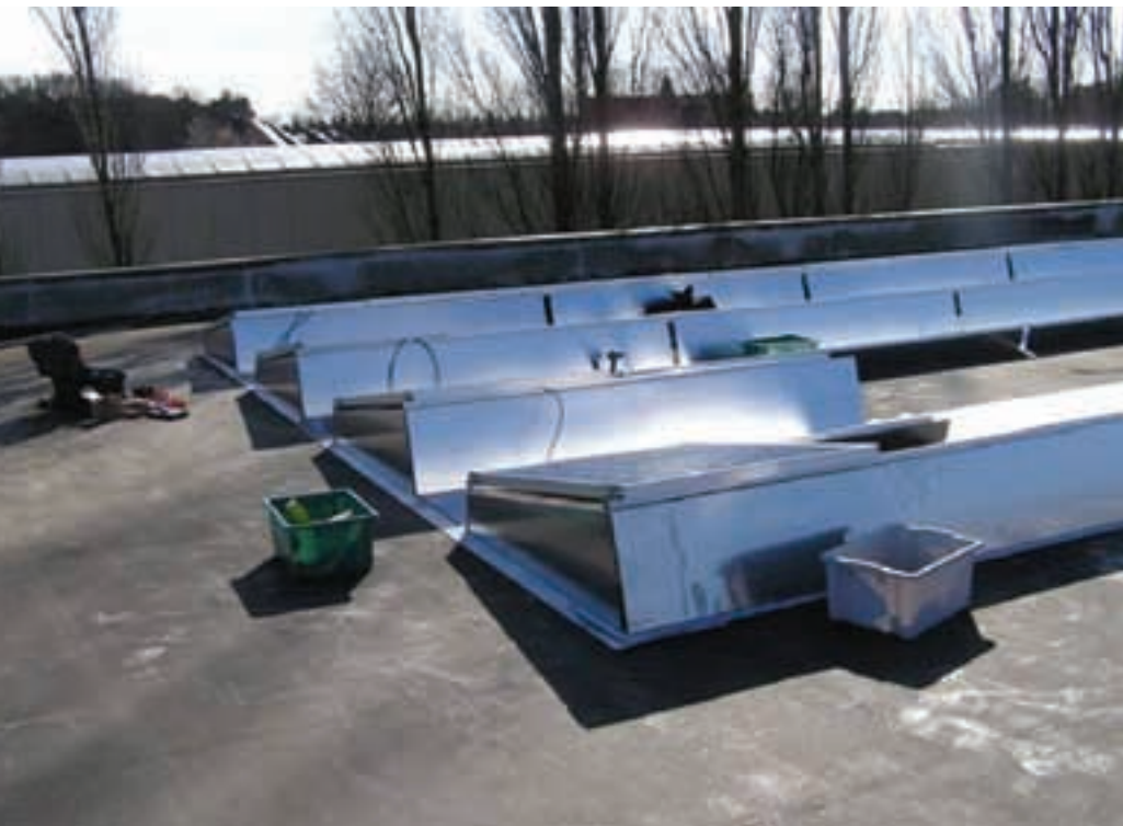
De Zonnegoot, ontworpen om zo min mogelijk windbelasting te dragen.
