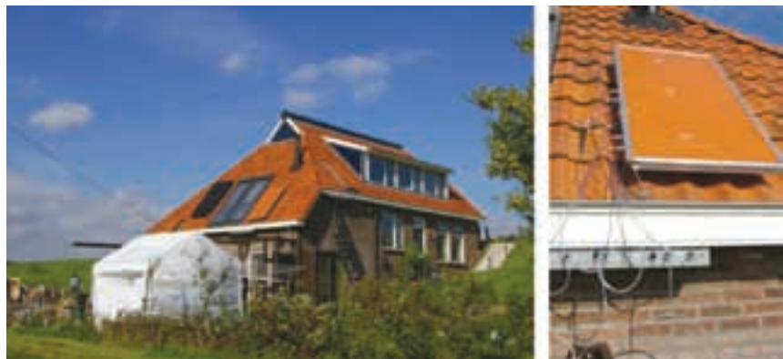
Opstelling voor het meten van winddrukken aan zonnepanelen.
