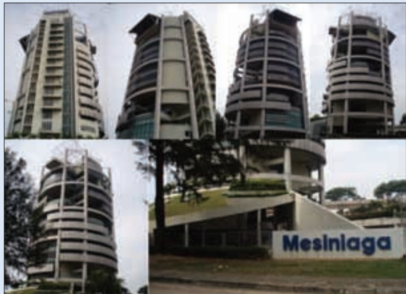
Mesiniaga in Kuala Lumpur ontworpen door Ken Yeang.
