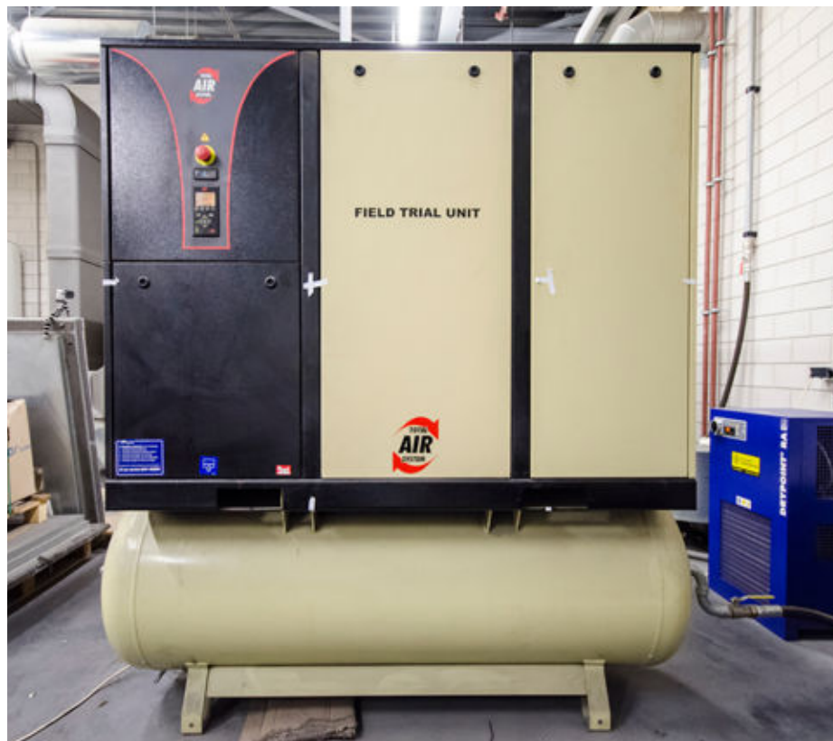
-Figuur 1- De compressor waarbij de meting met de akoestische camera is uitgevoerd
