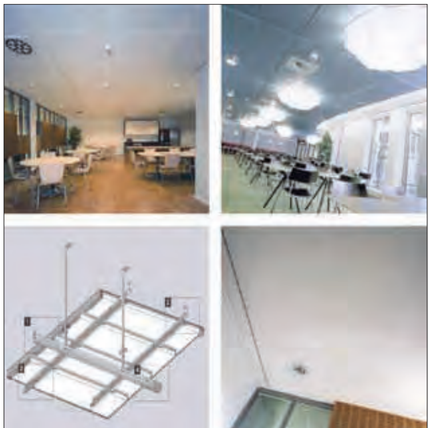
Diverse bouwkundige uitvoeringen van klimaatplafonds. Een rechthoekig C-band rasterplafond, een vierkant D-band rasterplafond, een rechthoekig J-bar plafond en een stucwerk klimaat plafond.
