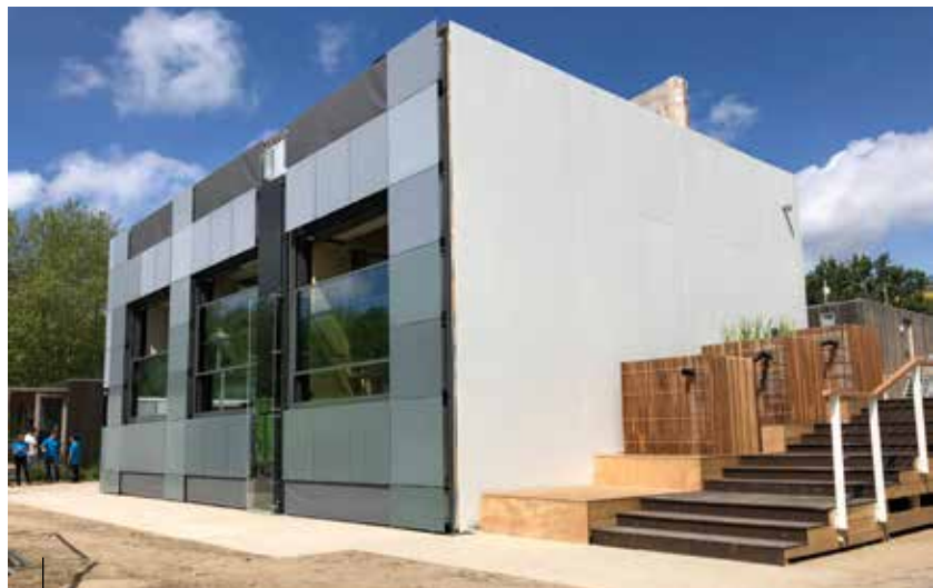
Foto 1: Op de GreenVillage van de TU Delft is een prototype gebouwd van de MOR: Modular Office Renovation.
