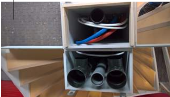
Foto 3: (boven) Een trapmodule met leidingenschacht voor de beneden- en de bovenverdieping, op de vrachtwagen. Klaar voor transport
